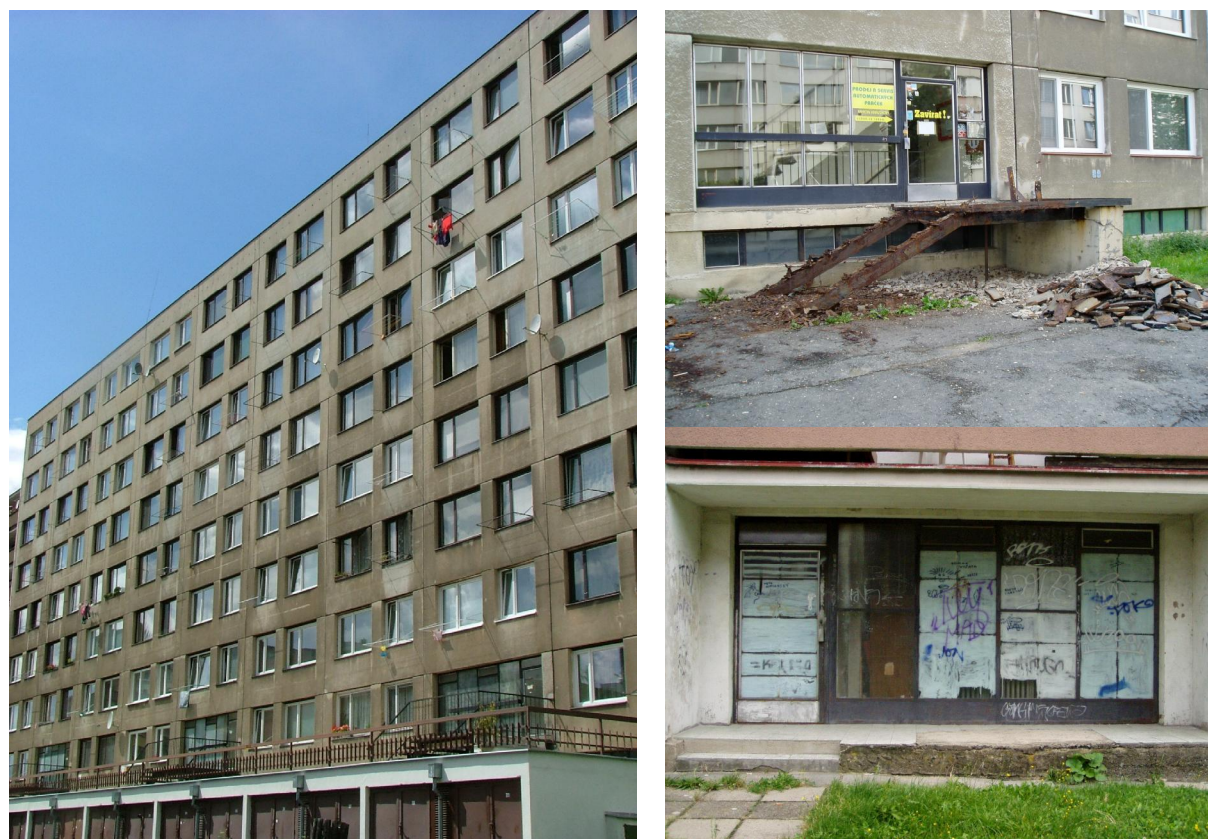
Obrázek 9.2: Panelová domy v původním stavu (Na Růžovém poli, Litevská, Americká)
