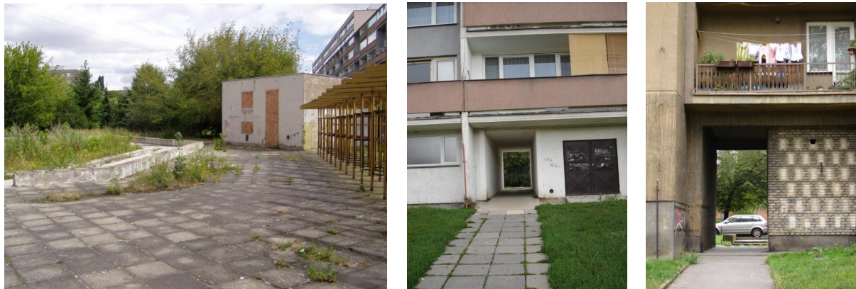
Obrázek 7.12: Zchátralé koupaliště a průchody v domech
