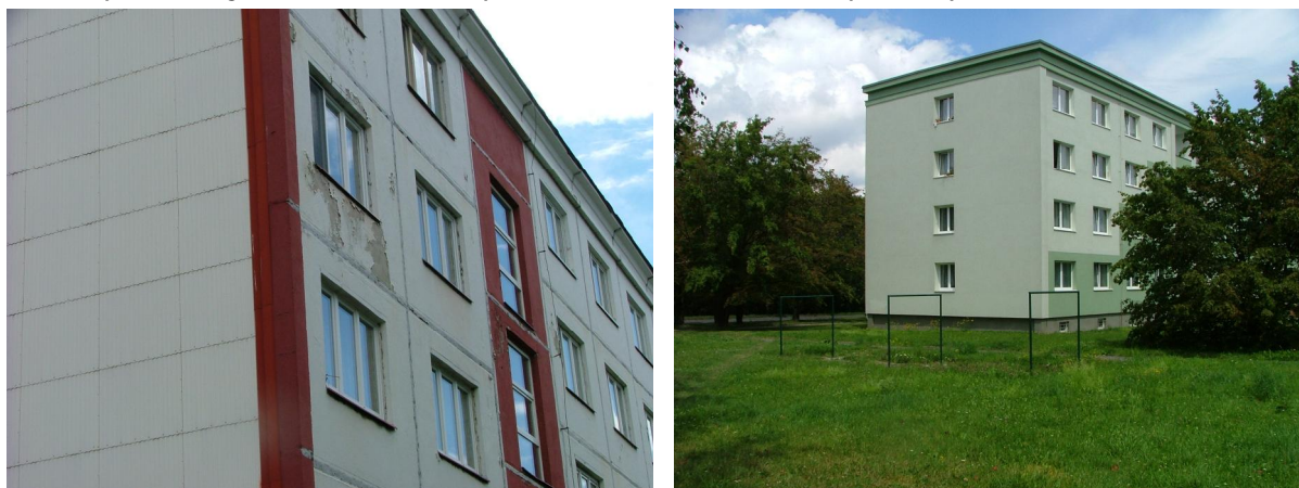
Obrázek 2.7: Mezi nejproblematičtější typy domů se řadí zejména G57, který je hojně zastoupen v nejstarších částech panelového sídliště. Dva příklady rekonstrukce.
