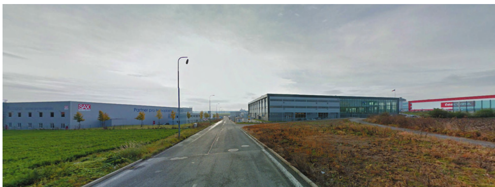
Obrázek 7.11: Komerční suburbanizace v obci Nupaky: komerční zóna Foto: Petr Koloušek, 2013
