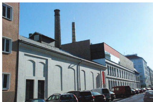
4.1 d Rozdílný fyzický stav budov v ulici Komunardů
