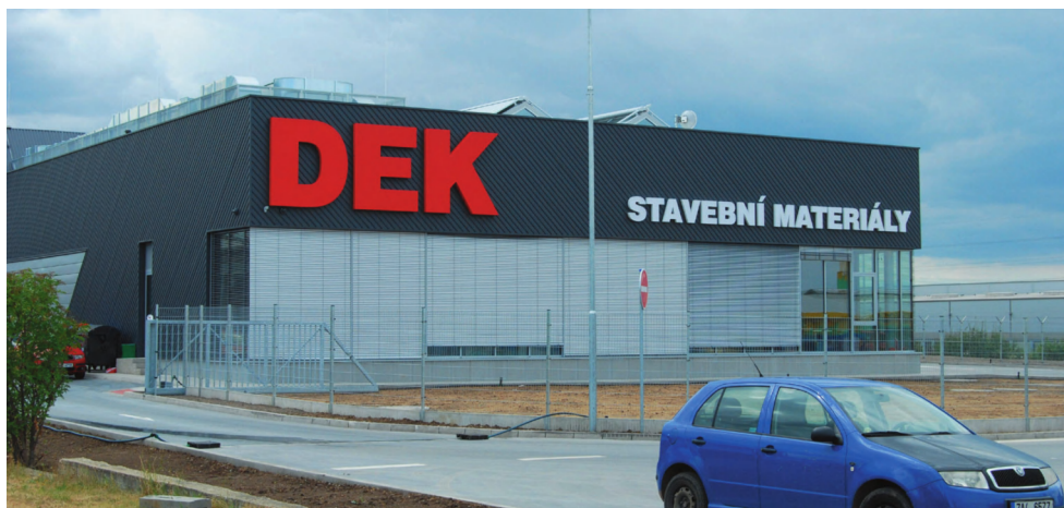
Obrázek 7.12: Komerční suburbanizace v obci Vestec: skladový a obchodní objekt Foto: Petr Koloušek, 2013
