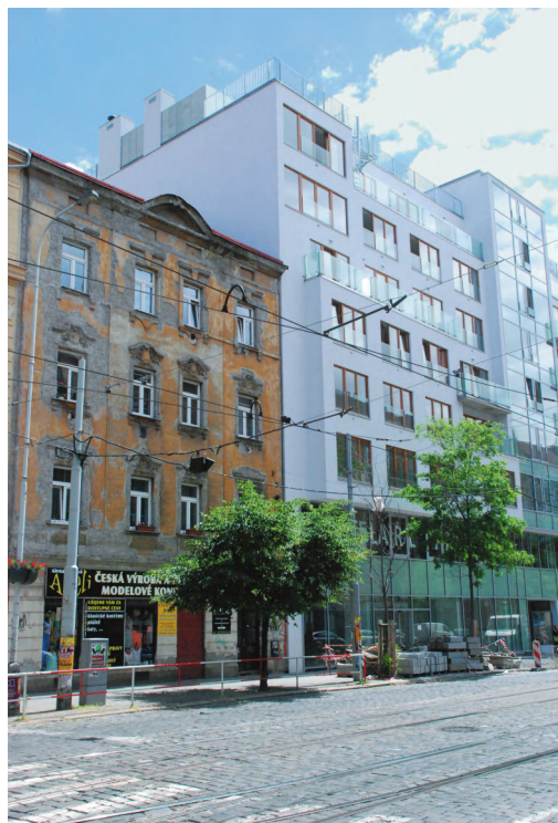
4.1 c Budova kulturního centra La Fabrika a designového centra Holport
