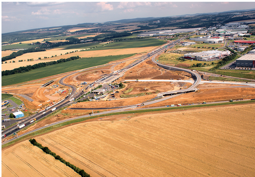
Obr. 2: Rozvoj komerční suburbanizace a dopravní infrastruktury mezi Modleticemi a Nupaky kolem dálnice D1. Zdroj: www.rsd.cz
