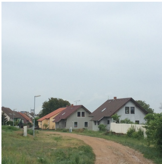
Obrázek 7: Výstavba rodinných domků v ulici Akademika Práta v Hrotovicích
