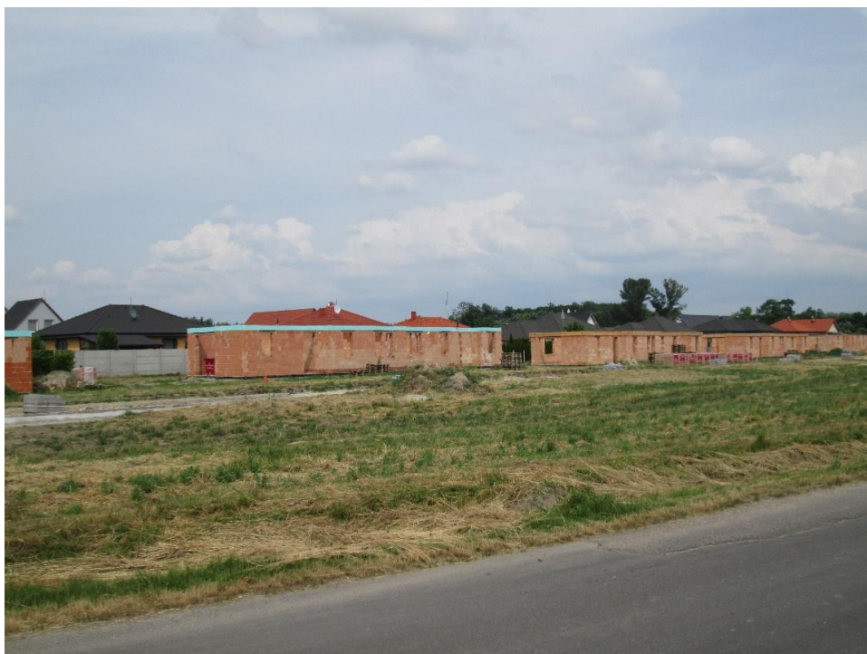
Obr. č. 14: Rajka – probíhající výstavba u hlavní ulice ve východní části obce
