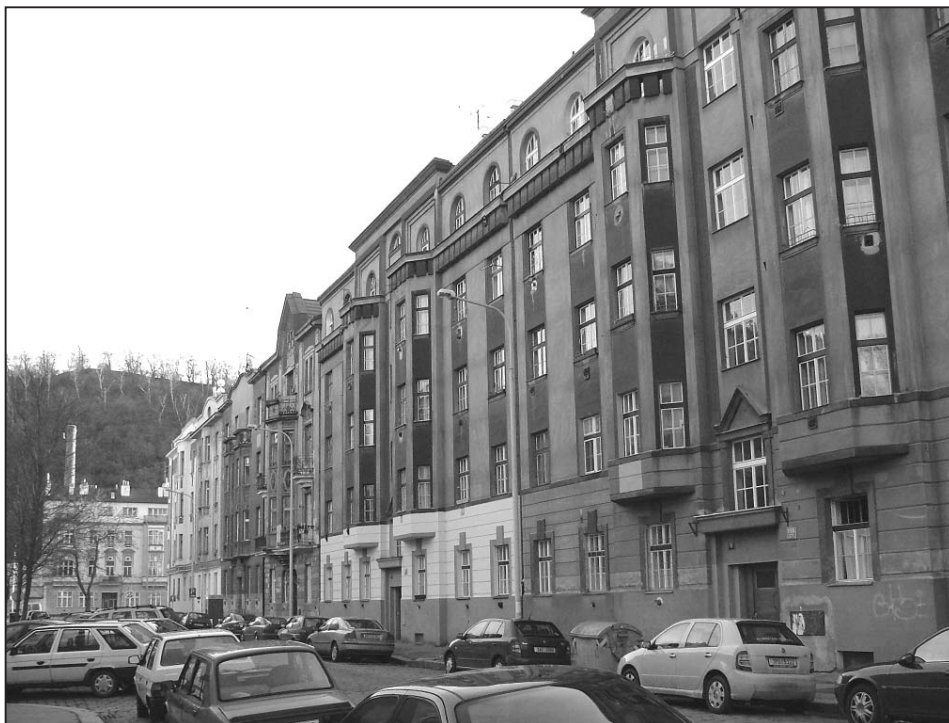
Obr. 3 – Rozmanitá úroveň oprav fasád karlínských domů. Foto M. Ouředníček (2006).
