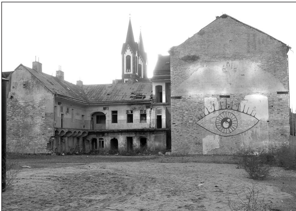
Obr. 2 – Kostel sv Cyrila a Metoděje, v popředí plocha uvolněná demolicí domu a tovární haly. Foto M. Ouředníček (2006).
